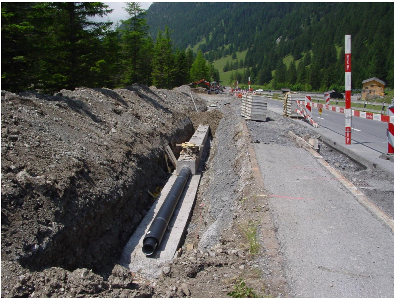
Baustelle HSK Malbun-Steg, Bereich Schneeflucht
