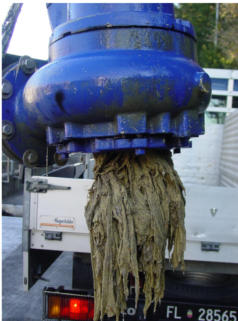
Verstopfte Pumpe im Zulauf ARA
