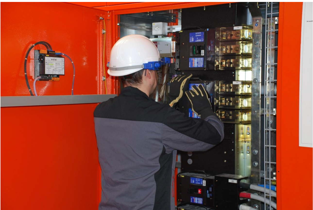
Unterhaltsarbeit an einer Hauptverteilung
