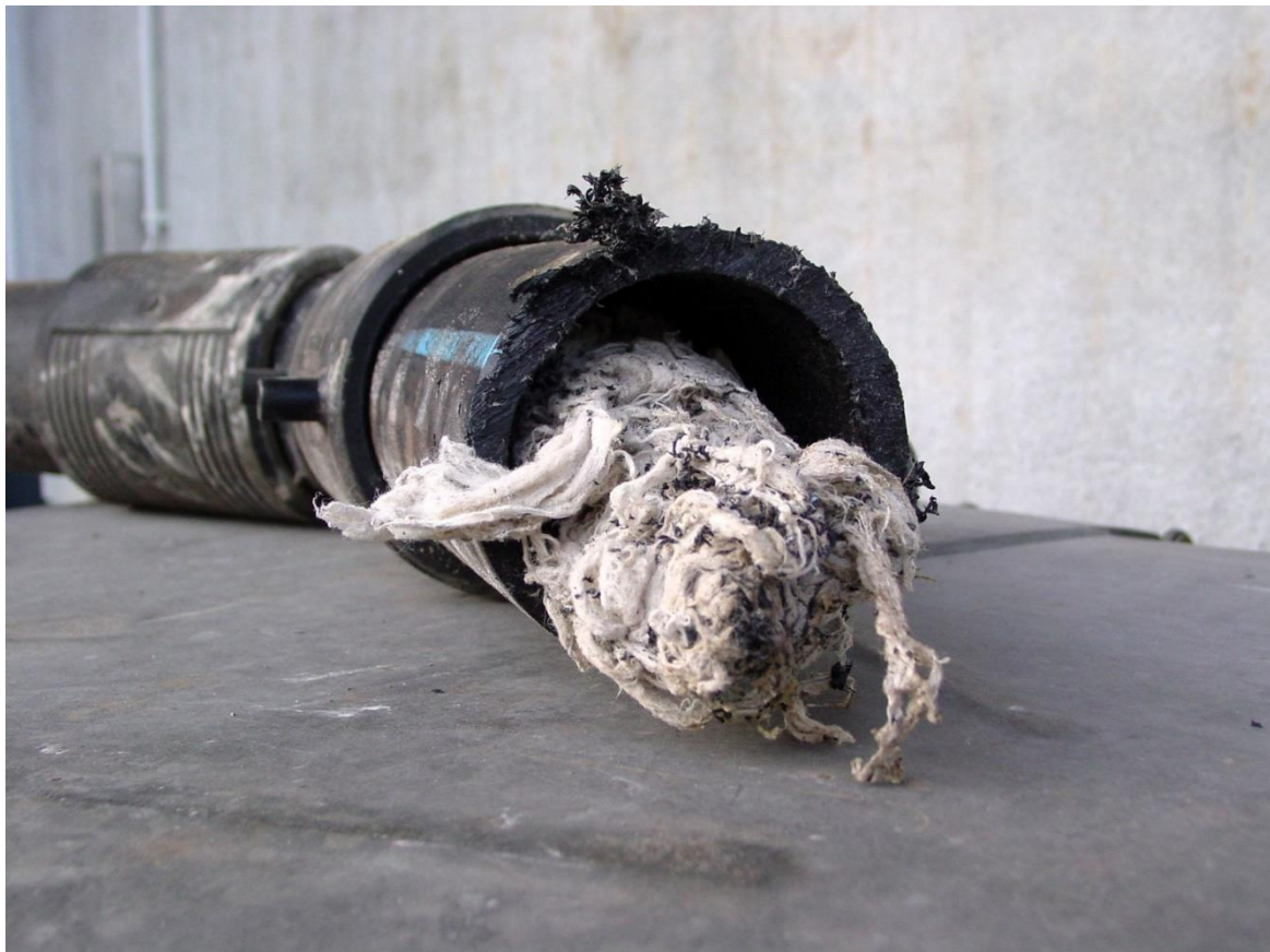
Verstopfte Pumpleitung im Brühlgraben
